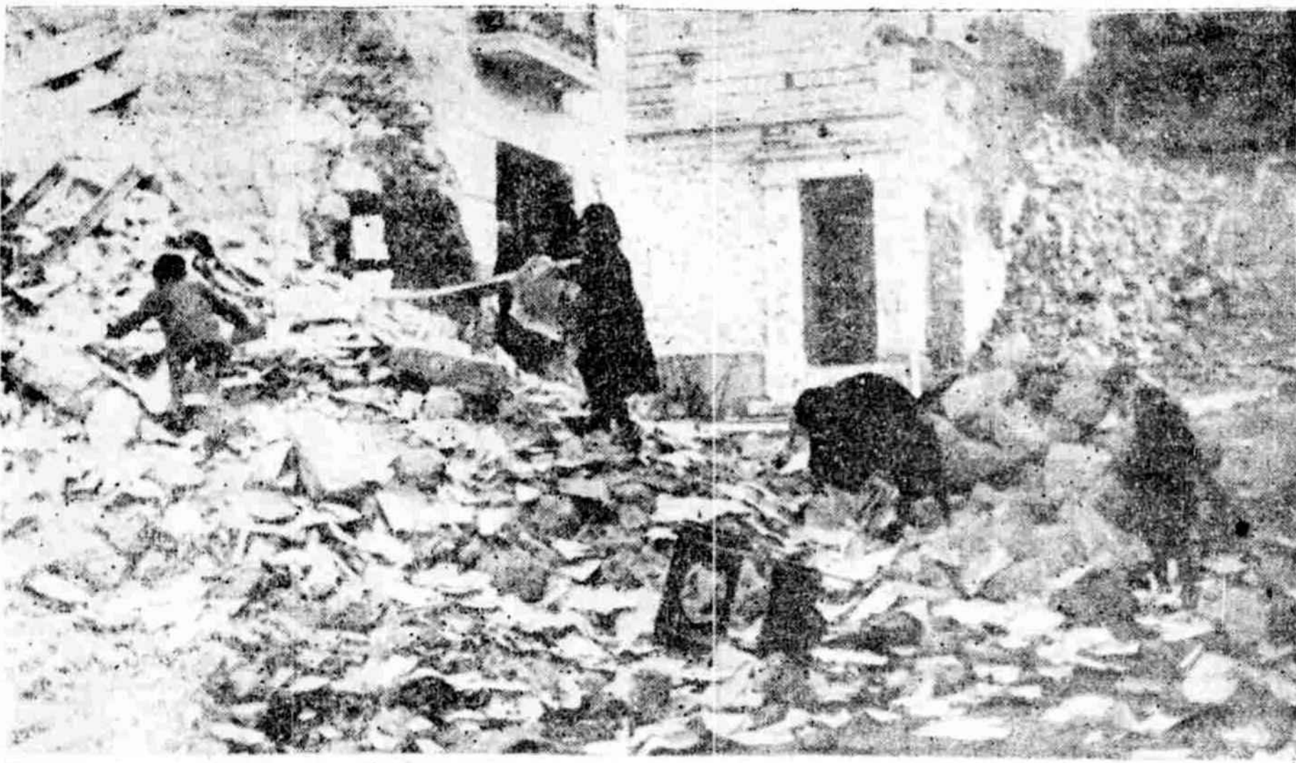
Οἱ δυστυχεῖς οἰκογένειαι πὺ εἶδαν τὰ σπίτια τοὺς ν' ἀνατινάζονται χωρὶς λόγον ἐπειτα ἀπὸ τηλεσίγγραφον ἑνὸς τετρατοῦ τῆς ὥρας ψάχνοντες μετὰ τὰς ἐλπίδας νὰ ὁρῶν κατὰ τὸν ὁδὸν τὸν ὁποῖον τοὺς.
